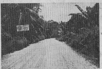
Proyectando su obra a través de todo el país el MOP está construyendo una carretera entre Limón y Moin. La gráfica corresponde a una sección de esa importante obra que vendrá a llenar una necesidad sentida durante muchos años por los numerosos habitantes de esa prestigiosa región.
